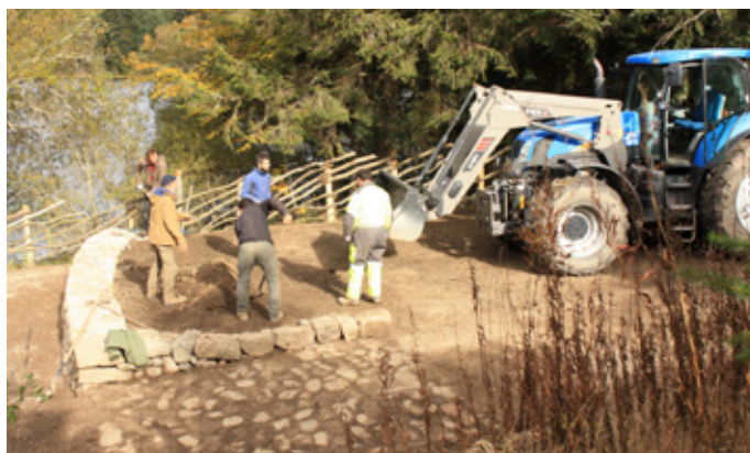
Construction d'un mur en pierre sèche et calade carrossable au Lac Malaguet (43) - Atelier Bivouac -
