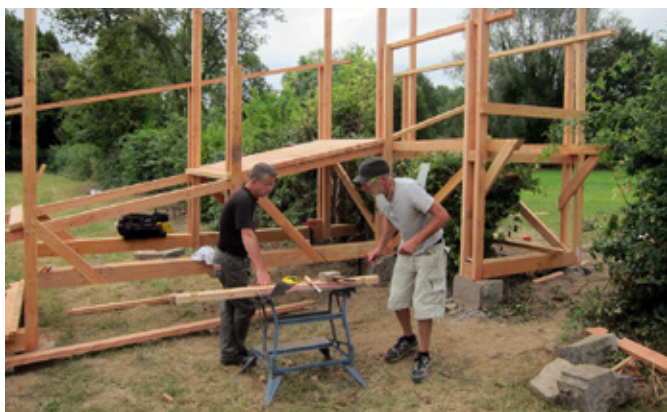
Réalisation chantier participatif pour Eclectic campagne La chambre d'eau (59) / construction bois / tressage de haies / plantation - Atelier Bivouac -
