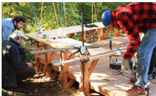
Réalisation d'une terrasse pour accueillir chantier participatif à Lanas sur la Place de l'Enclos (07)- Atelier Bivouac -
