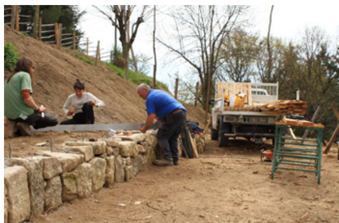
Réalisation du soubassement en pierre sèche avec les agents communaux
