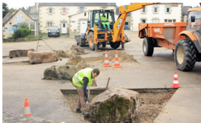
Découpe de l'enrobé, préparation des fosses et implantation des rochers par Bivouac et les services techniques./ scieur mobile / Atelier Bivouac -
