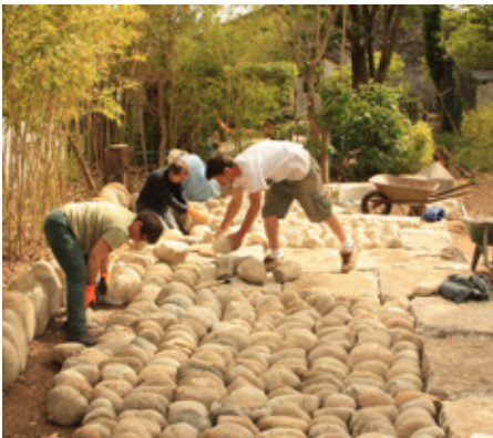
Atelier de réemploi de pierres issues d'une démolition pour la construction d'un nouvel espace public Lanais (07)
