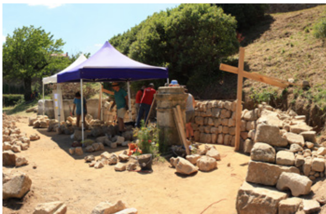
Construction collective d'un muret en pierre sèche et de mobilier en bois local
