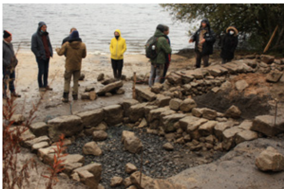
Chantier muret en pierre sèche et calade avec Elips
