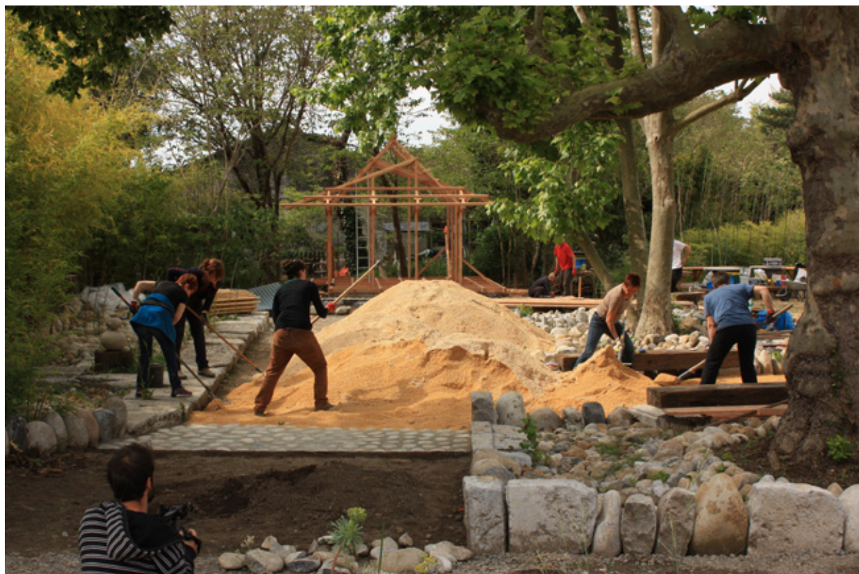
Atelier de réemploi et valorisation des pierres (issues de la démolition de l'ancien mur d'enceinte) dans la création d'une calade
